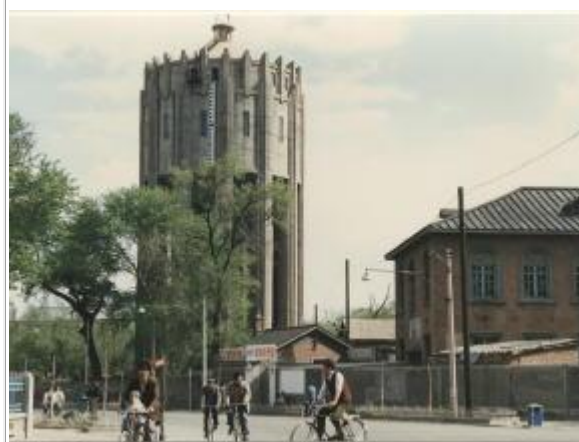
給水塔（西広場）
