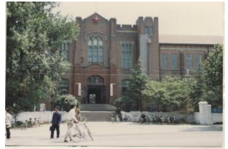
大連理工大学化工部（南満州工業専門 学校）
