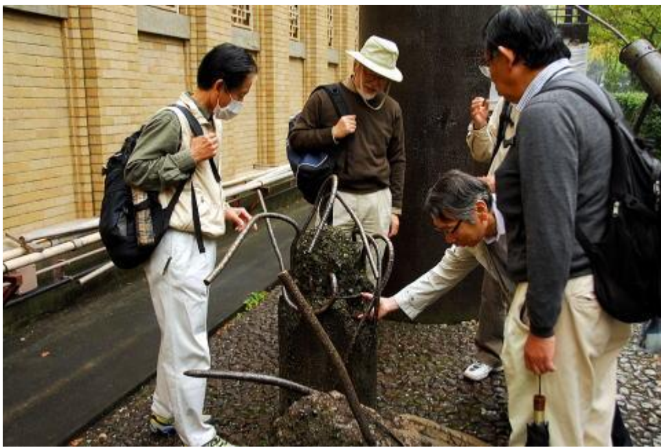
横網町公園あたりは大日本ビールの工場があったとか 震災による火災の熱でグニヤリと曲がった鉄筋 「太か鉄筋ば使うとるねえ」と建築関係者
